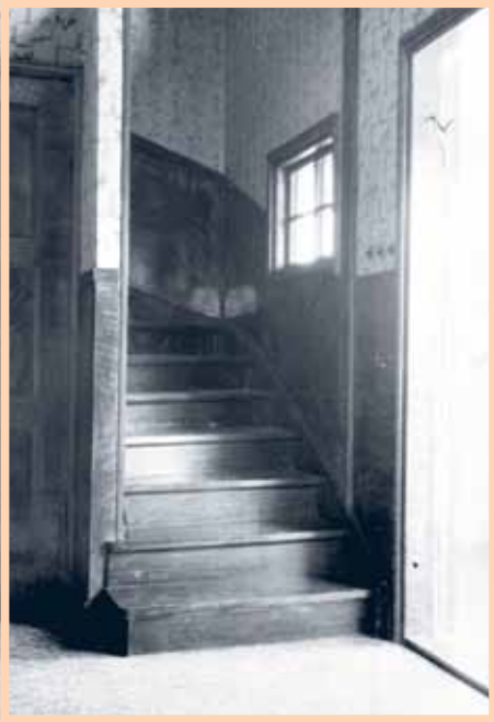
Nedre hallen med trappan till vindsvåningen, Beckombergavägen 128.
