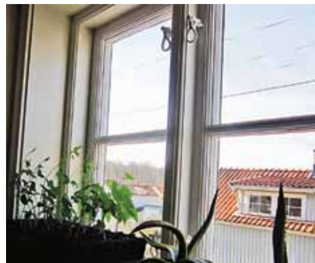
Niklas och Torgils fönster är specialtillverkade med originalprofil på bågar och lister och med beslag av originalmodell.
