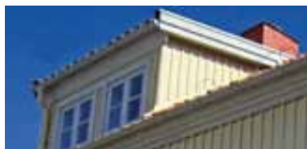
Kupans ytterväggar är beklädda med läkt som har den korrekta profileringen.
