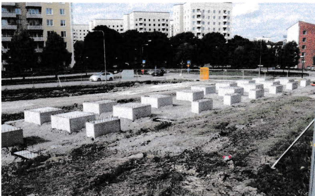
Bild 2 Snabba hus Räcksta, grundläggning 2018-09-20
