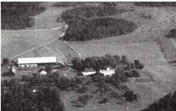
På Stora Ängbys åkrar byggdes den nya trädgårdsstaden. Gården hade betydligt fler byggnader för djur och personal än de som finns kvar i dag.
