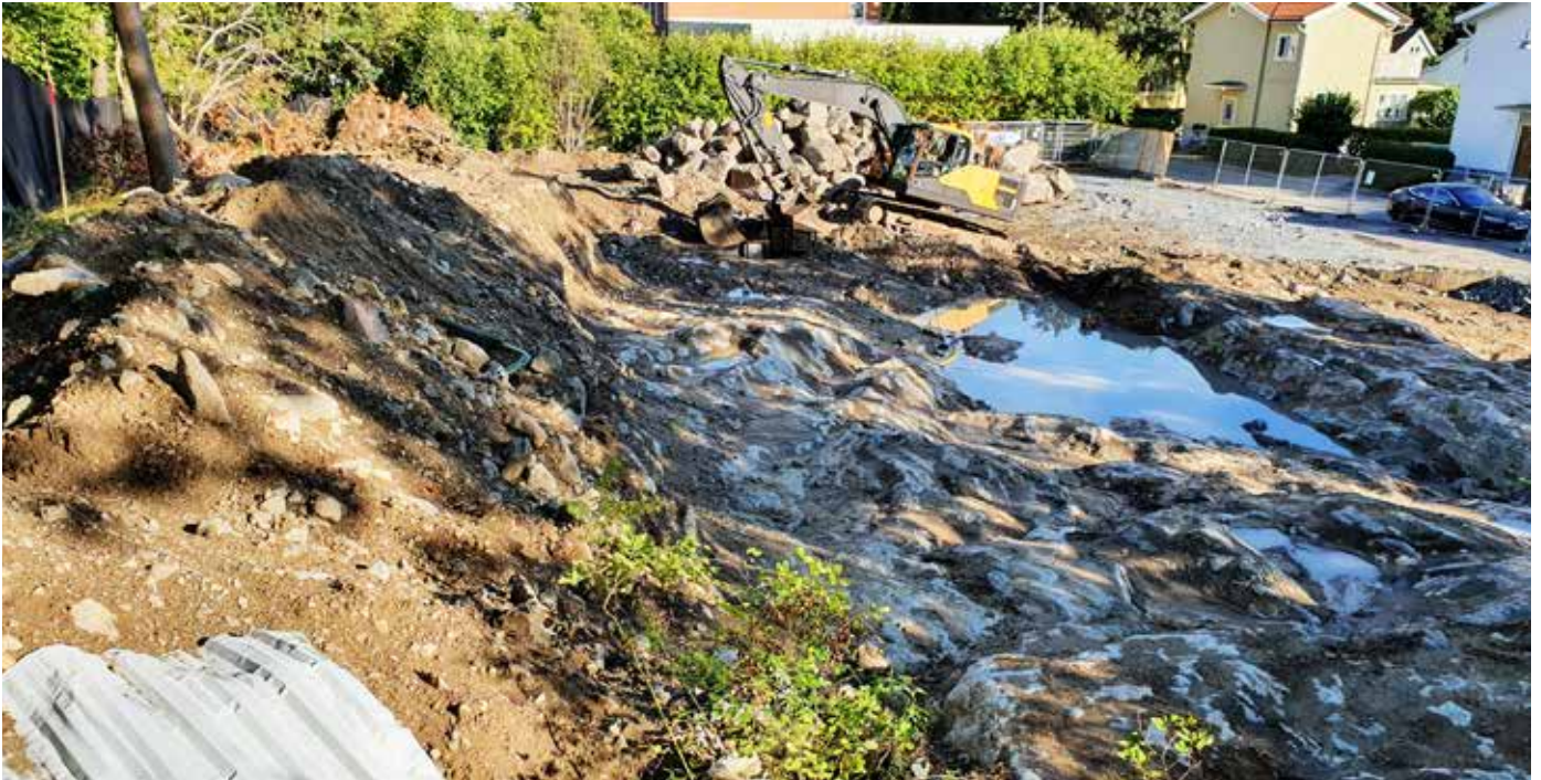
Schaktningen av radhustomten är påbörjad. Stora volymer jord ska bort och det verkar också bli nödvändigt med sprängningsarbete.
