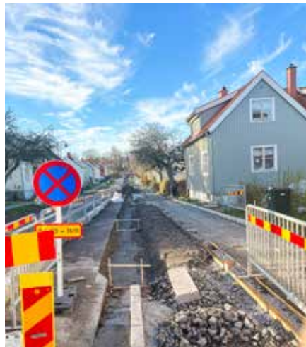
Stora Ängby allé har under hösten grävts upp och fått nya växtbäddar.
