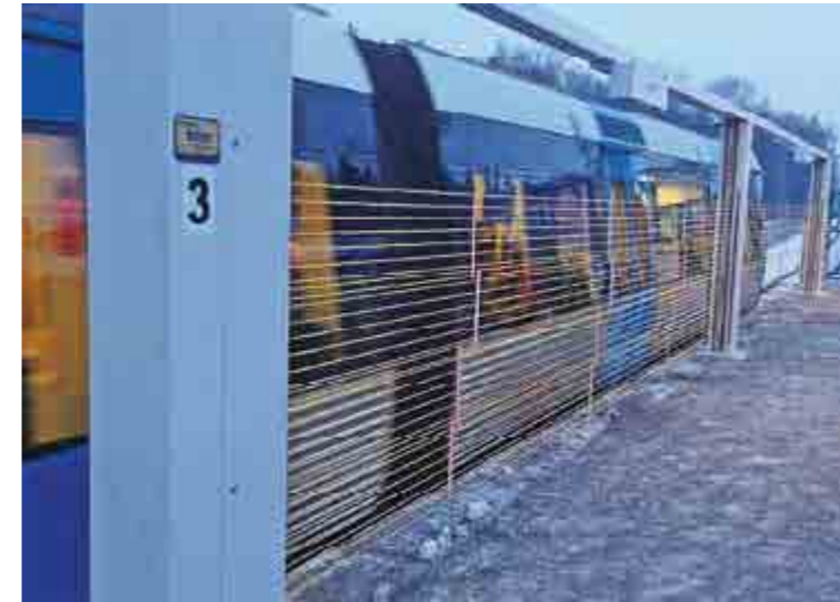
Flera olika typer av plattformsdörrar har testats. När tåget står stilla vid perrongen öppnas plattformsdörrarna.
