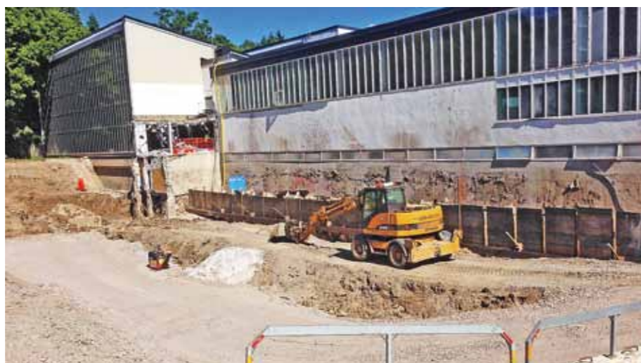
Nu är renoveringen och ombyggnaden av Åkeshovs sim- och idrottsanläggning igång. Bland annat grävs för ytterligare en 25-metersbassäng.
