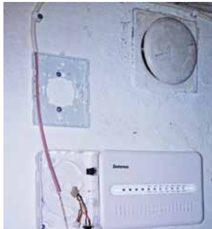
Vartannat hushåll i Norra Ängby har nu fiber indraget. Frågor om fiberinstallationer kan ställas till openfiber@teliasonera.com
