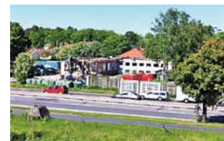
27 maj 2012. Rivning pågår, innegården syns nu.
