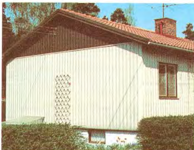
Måla inte gavelspetsen i avvikande färg. Fasaden splittras och överdelen ger ett "tungt" intryck.
