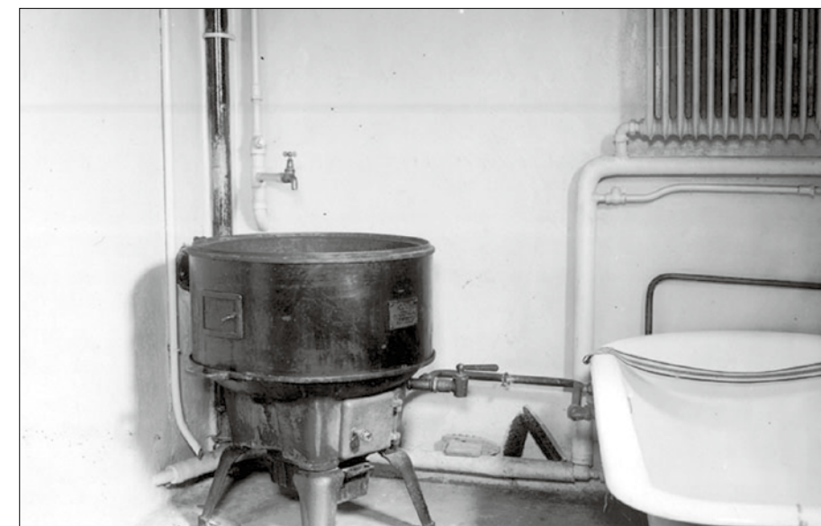
En tvättstuga kombinerad med badrum i källaren på Beckombergaavägen 128 i Ängby småstugeområde 1932. Foto Stockholms stadsmuseum.
