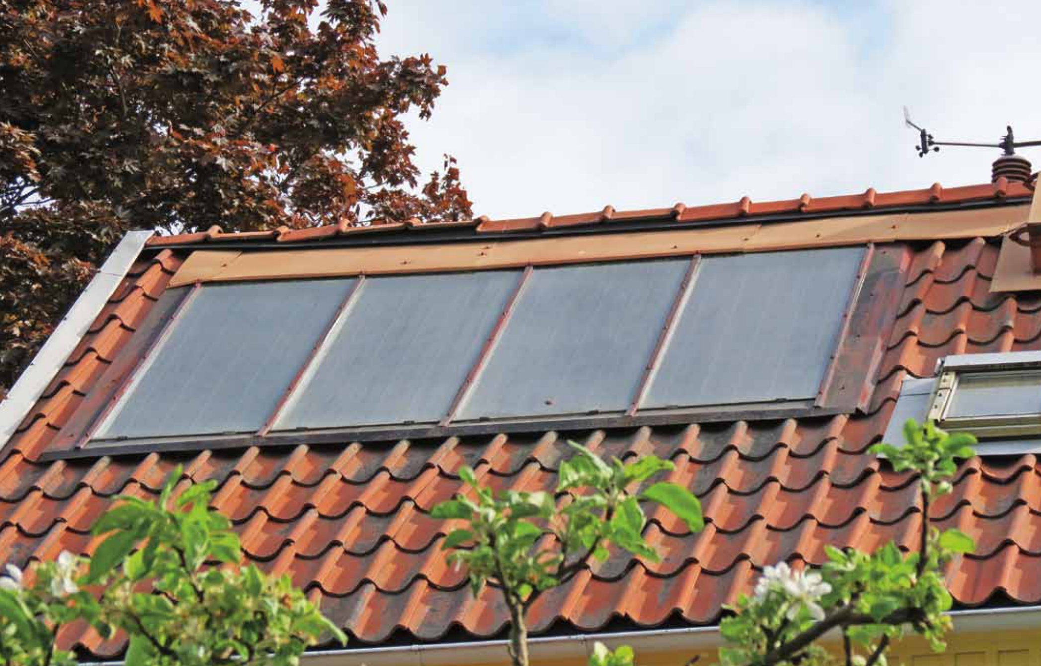
Några hus i Norra Ängby har solceller på taket. Men det krävs byggnadslov och inom områden av riksintresse för kulturminnesvården finns speciella krav på hur man monterar panelerna.
