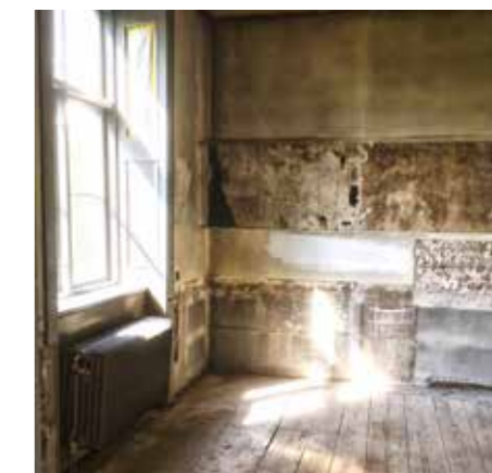
Köksrummet är ännu helt urblästa. En ny hyresgäst får lämna önskemål på köksinredning.
