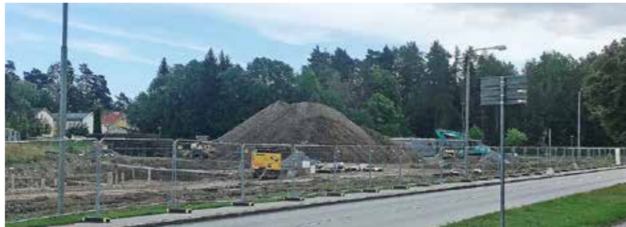
Svenska Bostäder har lämnat in ansökan om ändringar i bygglovet för de "snabba husen" – trots att grundarbetena redan har kommit långt. Bakom inhägnaden vid Räckstavägen kan man se en jättelik sandhög. Man har redan grävt för grunden och lagt ner vatten- och avloppsrör med mera.
