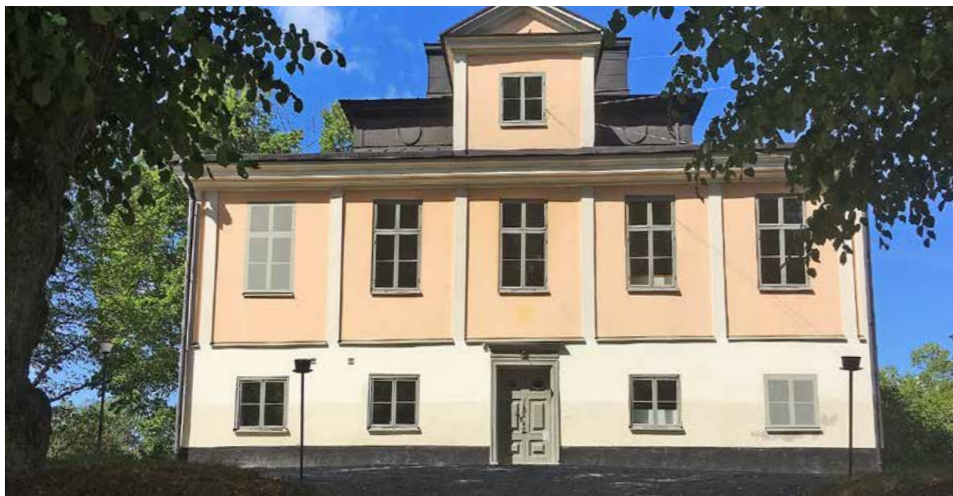
Slottet i Norra Ängby har stått tomt i snart fyra år. Det har renoverats fint både ute och inne men Stadsholmen AB har inte hittat någon ny hyresgäst.
