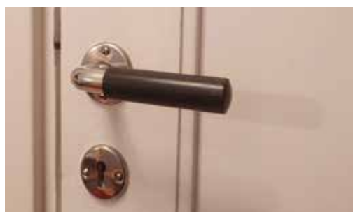
Typiskt för funkismodellerna i hus som byggdes senare är att metalldelarna helt saknar utsmyckning och att greppet för handen är av bakelit, antingen benvit eller svart.
