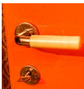
Typiskt för funkismodellerna i hus som byggdes senare är att metalldelarna helt saknar utsmyckning och att greppet för handen är av bakelit, antingen benvit eller svart.
