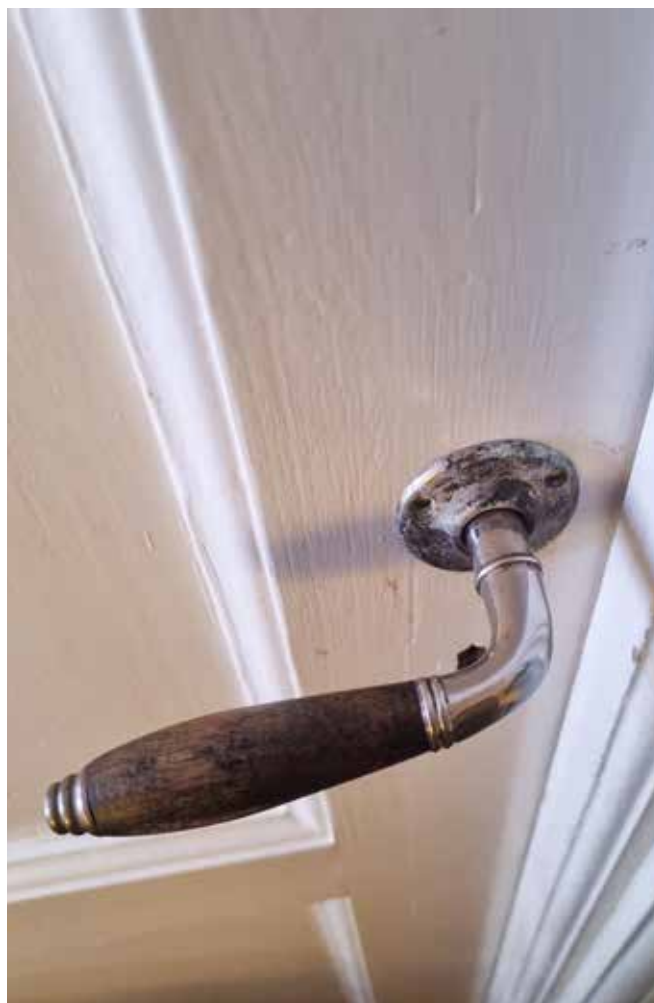
Dörrtrycke 20-tal. Trädelen kunde variera i form, och metalldelen har någon form av utsmyckning, t ex en eller flera ringar och änden på handtag avslutad med en knapp, av varierande form.
